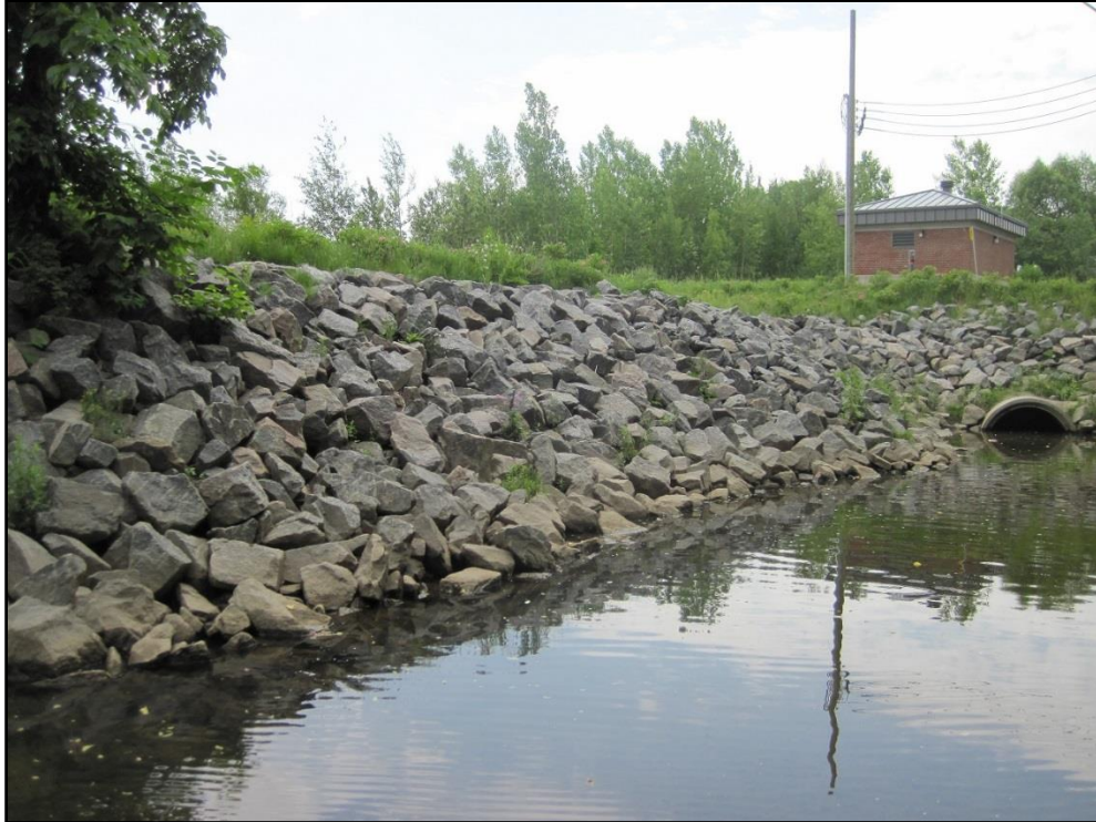
Photo 3 Enrochement existant qui sera végétalisé dans le contexte du projet, PK 3+050 (rive droite, juin 2012).
