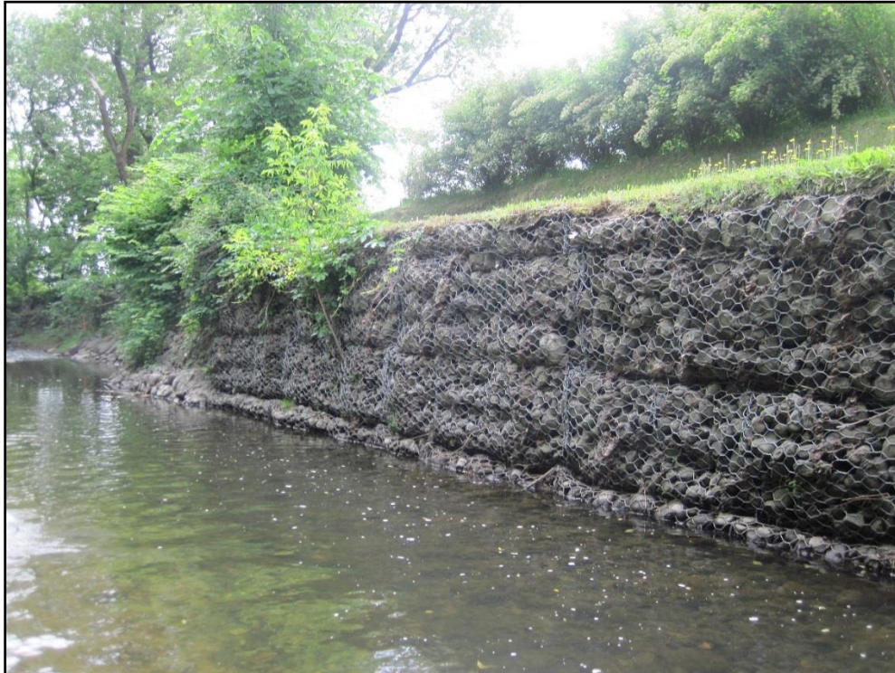
Photo 6 Ouvrage de stabilisation existant qui sera remplacé par un enrochement végétalisé dans le contexte du projet, PK 3+650 (rive droite, juin 2012).
